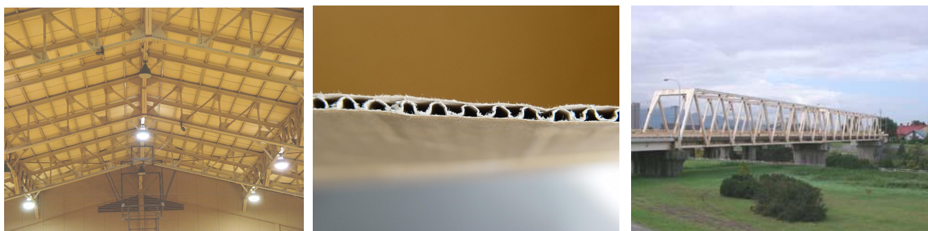
図3 トラス構造の例（左：体育館の骨組、中：段ボール 右：上白石橋）
