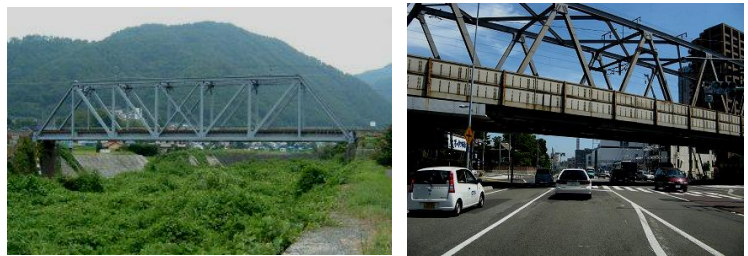
図 2 代表的なトラス橋（ワーレントラス）
