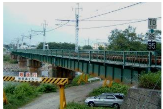
図 1 桁橋（ガーター橋）
