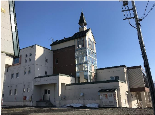
構造上、距離が測れない塔部分
