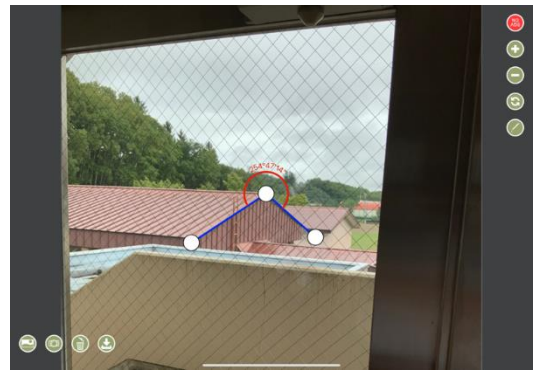
図1 Angle Meterを使った角度の計量(建物の屋根)
